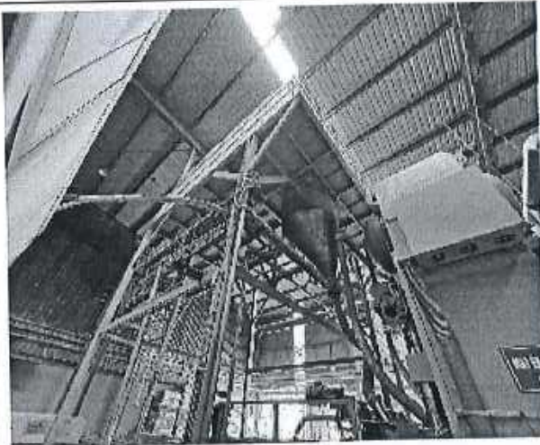
Kết cấu thép sàn sàng rung và băng tải
