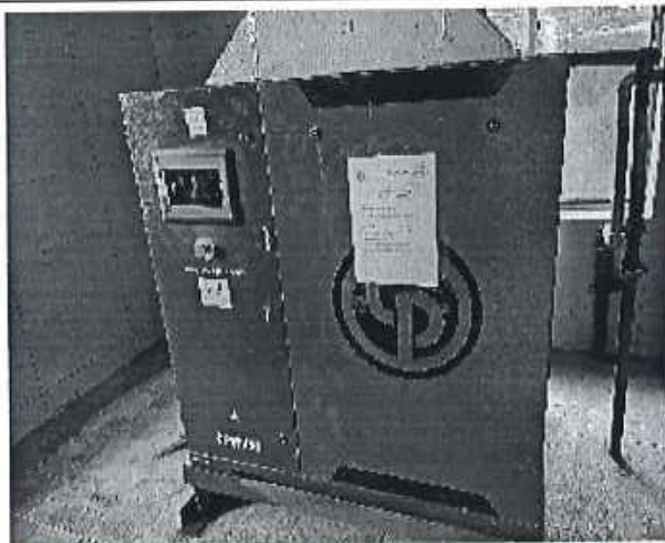
Máy nén khí Chicago Pneumatic CPMV50
