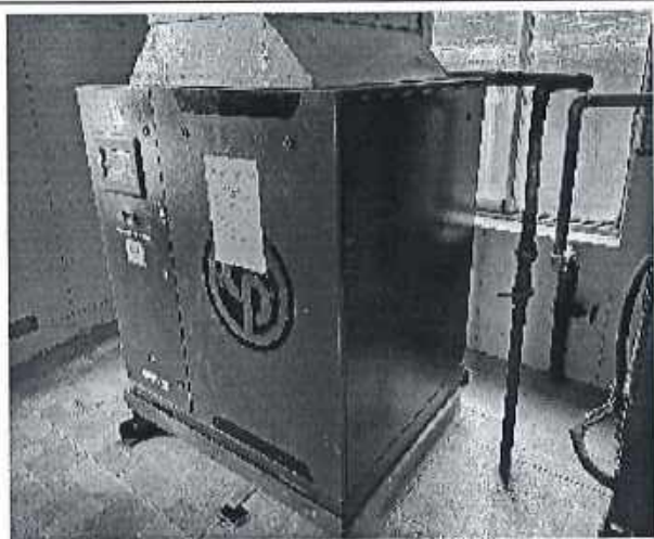
Máy nén khí Chicago Pneumatic CPMV50
