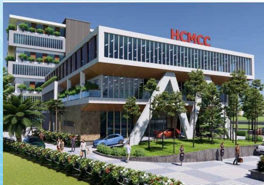
BĐS Công nghiệp
