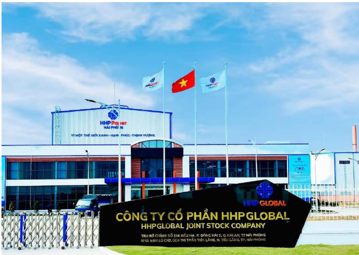
Nhà máy HHPPaper Hải Phòng tại CCN TT Tiên Lăng
