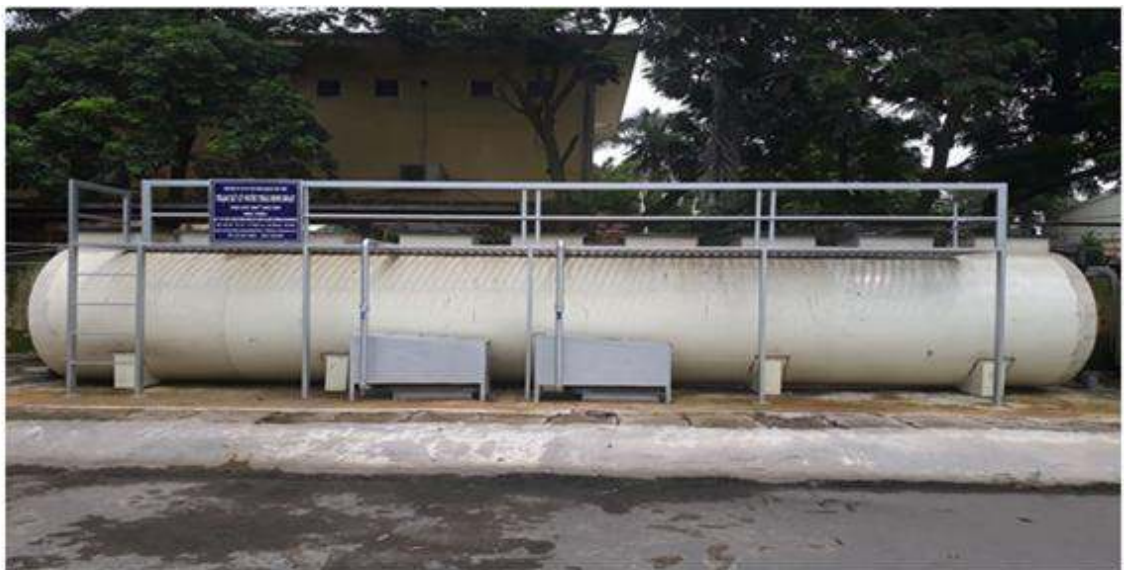
Hình ảnh: Hệ thống xử lý nước thải công suất 30 m 3 /ngày.đêm tại 3 nhà máy thức ăn chăn nuôi KCN Khắc Niệm
