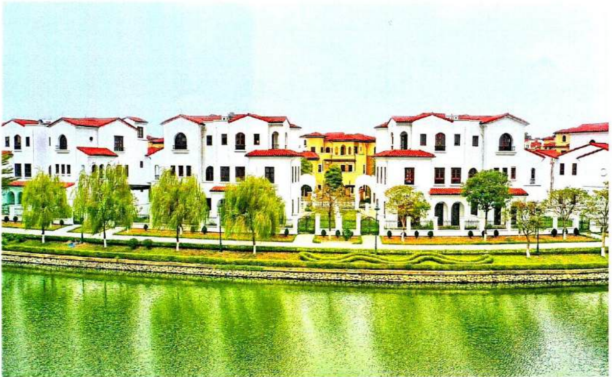
(Một số hình ảnh dự án Khu đô thị Nam An Khánh)/ (Some images of the Nam An Khánh Urban Area Project)
