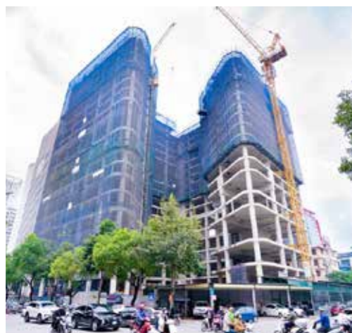
Công trình Hà Nội Hilton West
